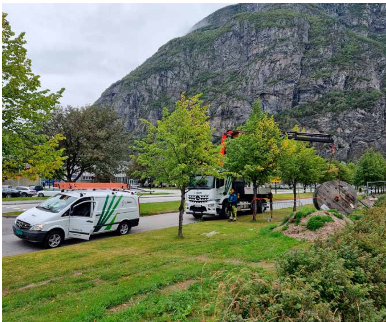
Kabeltrekking til Sunndal Helsecenter. Foto A. Nedal
