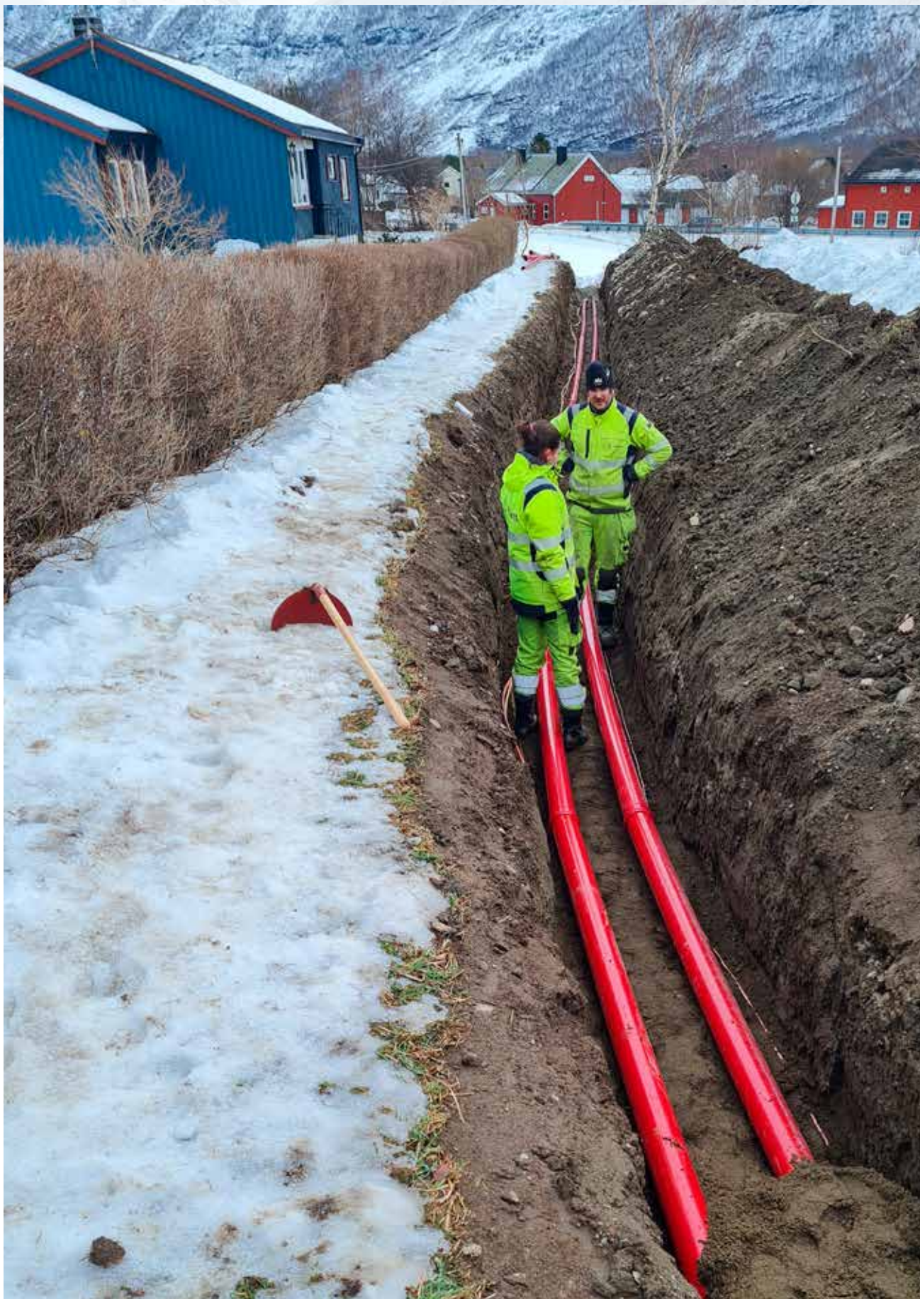
Ombygging lauspent øvre Furu. Foto A. Nedal
