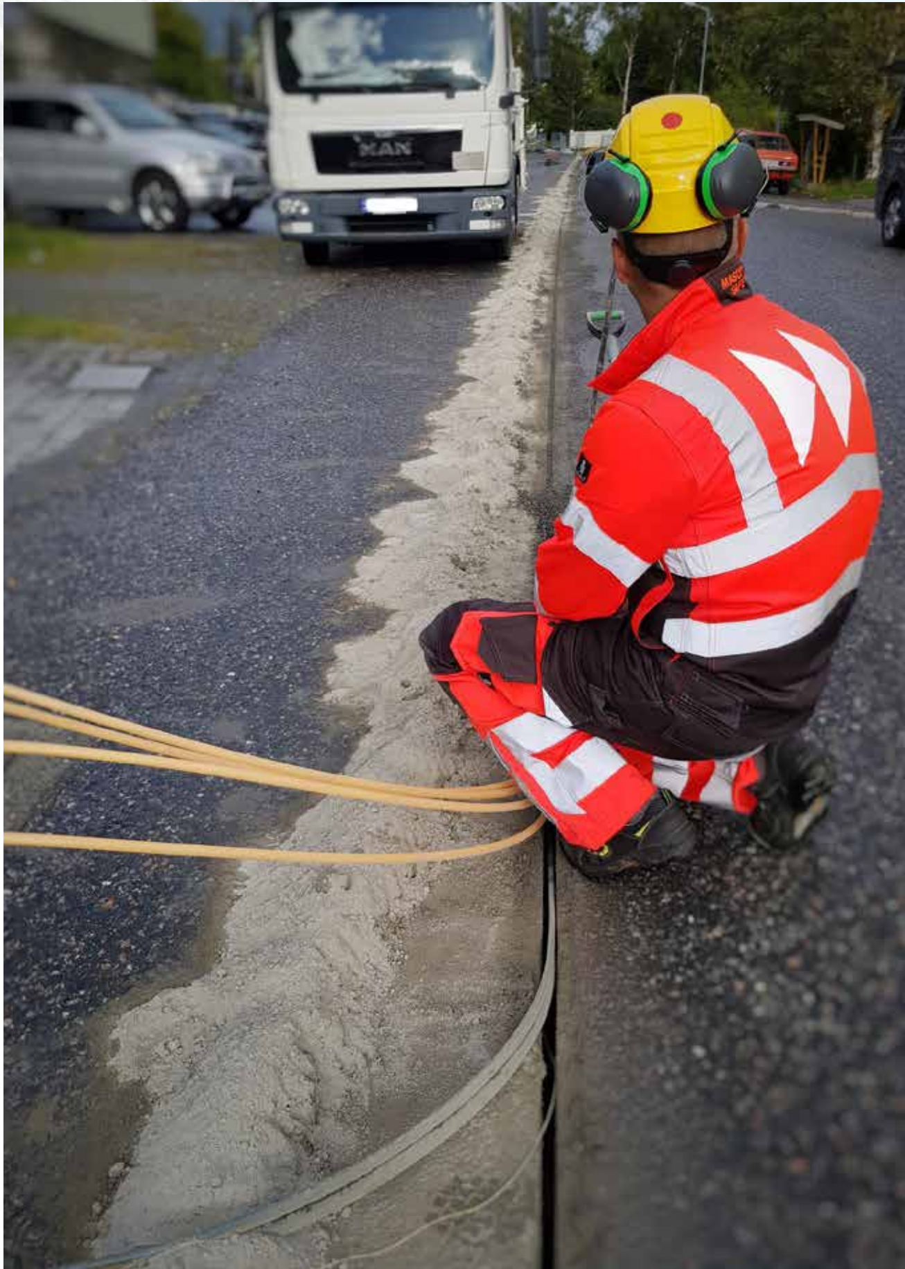
Trenching av fiber
