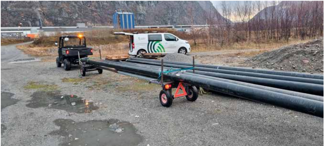
Transport av fjernvarmerør. Foto G. Tvedt
